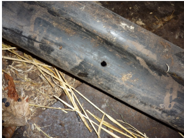
Vandingsrør (Ø90) anvendes til luftindblæsning. Efter ibrugtagning: Slangerne mellem fliserne har en hulafstand på 60 cm.
