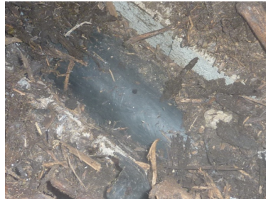
Vandingsrør (Ø90) anvendes til luftindblæsning. Efter ibrugtagning: Slangerne mellem fliserne har en hulafstand på 60 cm.
