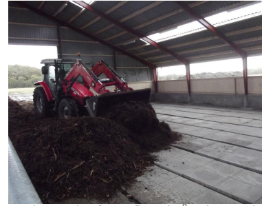
Her køres den første flis ind på gulvet med indbygget beluftning.
